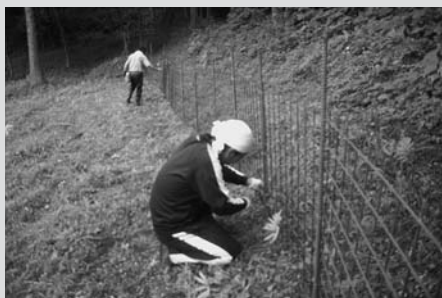
地域でのイノシシよけ防護柵の設置作業
