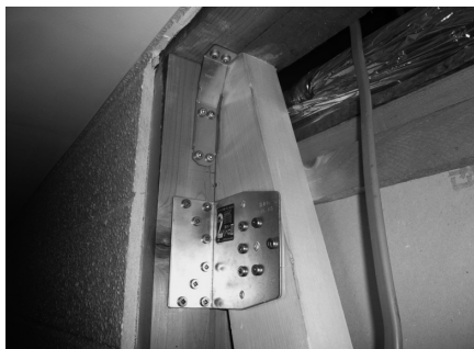
耐震工事の施工例
