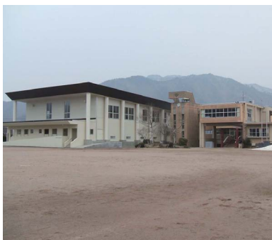
⑤ 本郷小学校 屋内運動場（左側）
