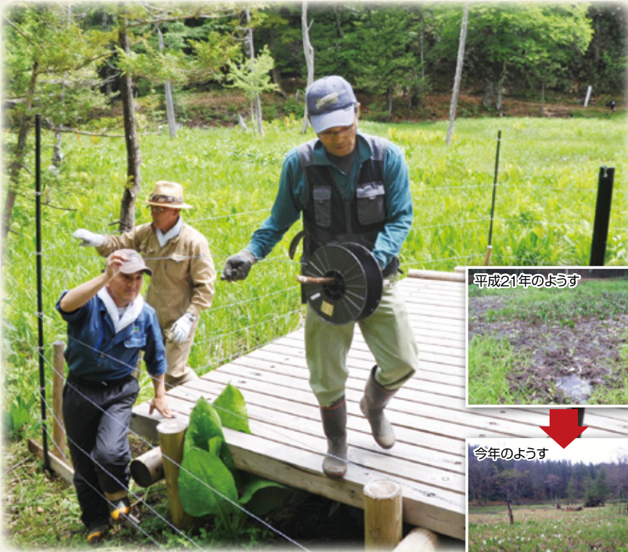
群生地を取り囲むように電気柵を設置するみなさん（庄川町寺河戸）
