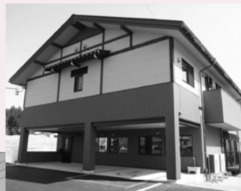
ほのぼの朝日まつもとの家 (1階小規模多機能施設部分) 松本町
