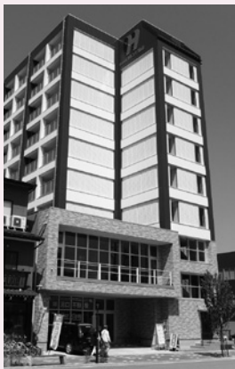
レジデンス高山駅前 (駐車場、廊下、階段) 花里町6
