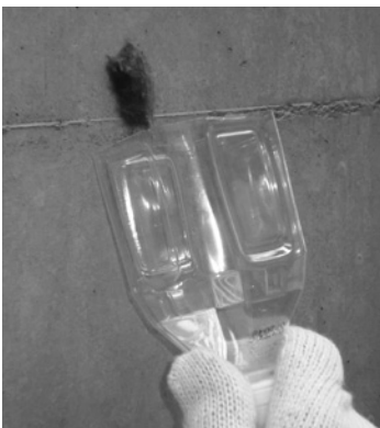
ペットボトルを半分にした容器でそぎ落とすと安価で効果的です
