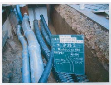
地中に埋められる電線やパイプ
