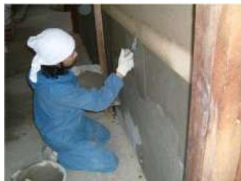
伝統建築の修理
