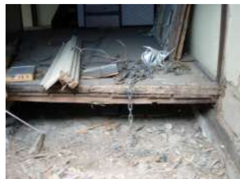
大規模修理が必要な町家
