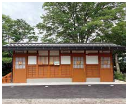
▲北山公園の公衆トイレを修繕 (環境を守る取り組み)
