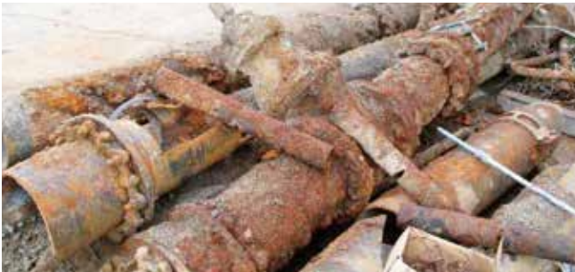
▲水道管の老朽化
