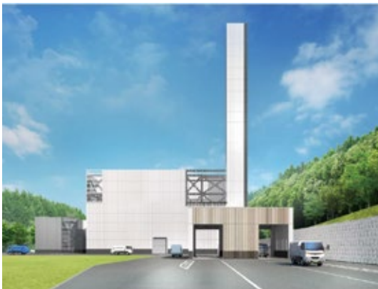
▲計量棟・工場棟 入退場側
