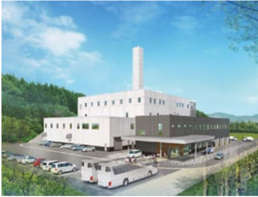
▲管理棟 正面玄関側
