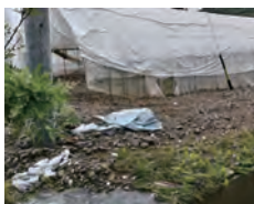
繰り返される土砂・水害 (塩屋町)
