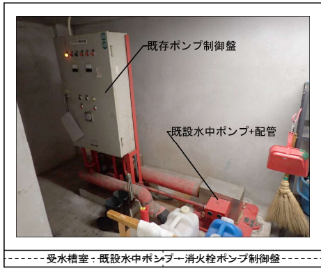
受水槽室：既設水中ポンプ+消火栓ポンプ制御盤
