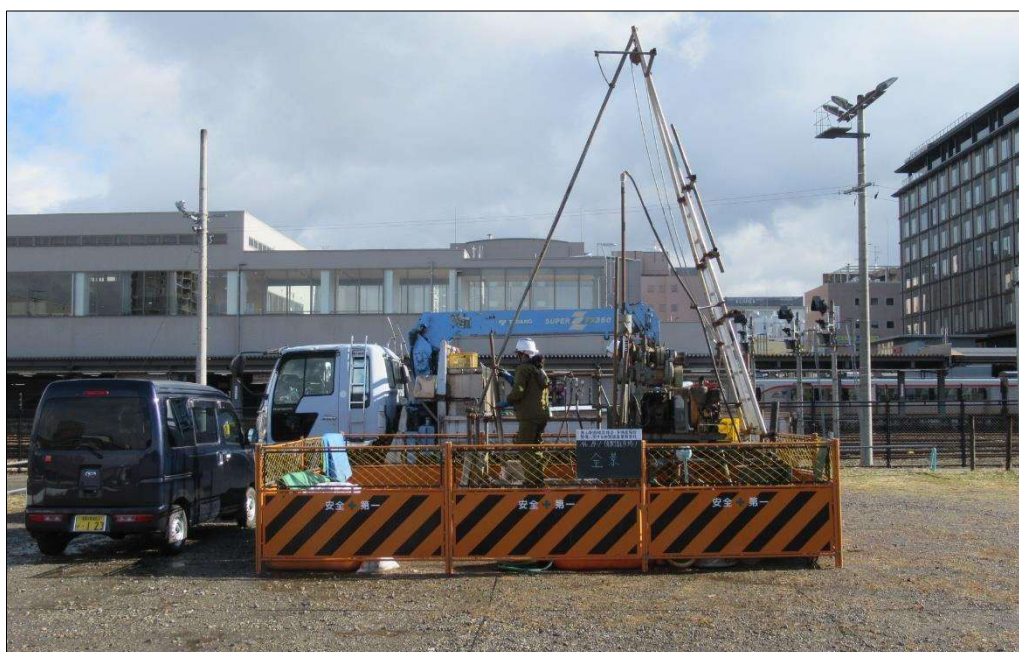
写真2.1.2 ボーリング作業場所の全景(No.B-1地点)
