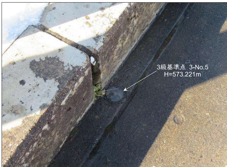
写真2.1.4 測量基準点近景
