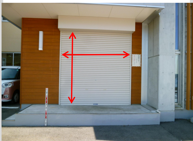
(3) コンテナを搬入する配膳室搬入口
