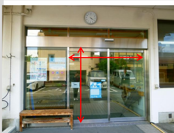
(3) コンテナを搬入する配膳室搬入口
