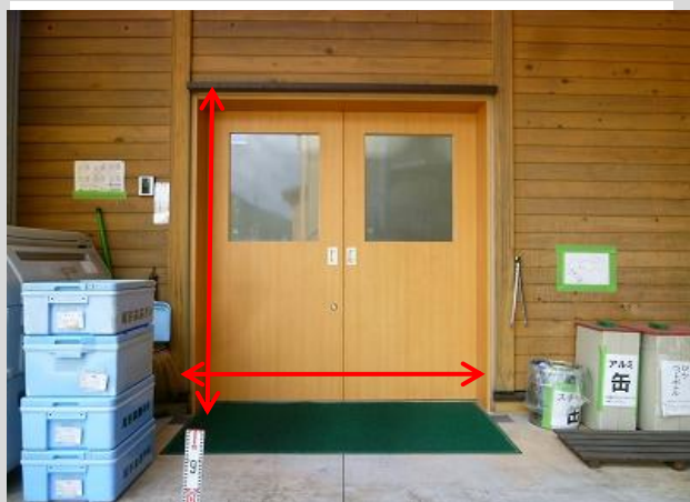
(3) コンテナを搬入する配膳室搬入口
