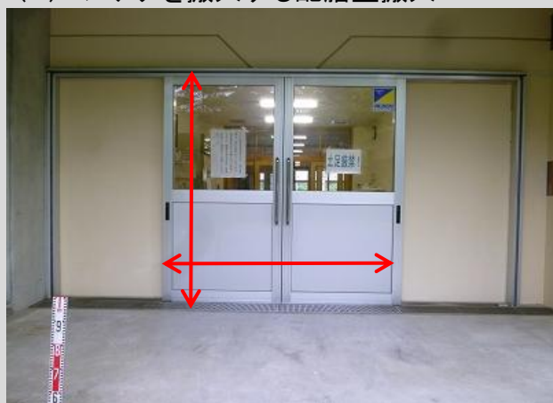
(3) コンテナを搬入する配膳室搬入口
