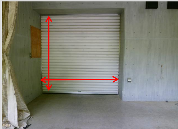
(3) コンテナを搬入する配膳室搬入口
