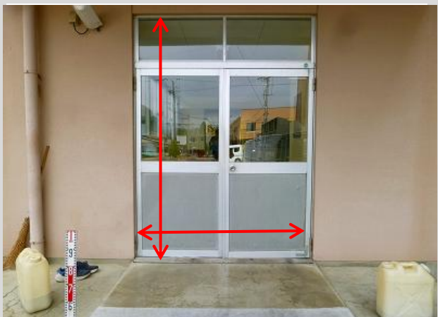
(3) コンテナを搬入する配膳室搬入口
