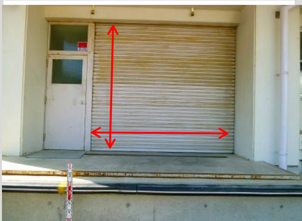
(3) コンテナを搬入する配膳室搬入口
