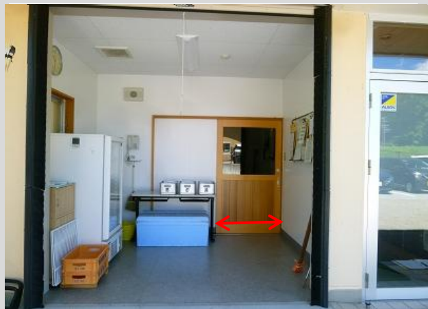
(3) コンテナを搬入する配膳室搬入口
