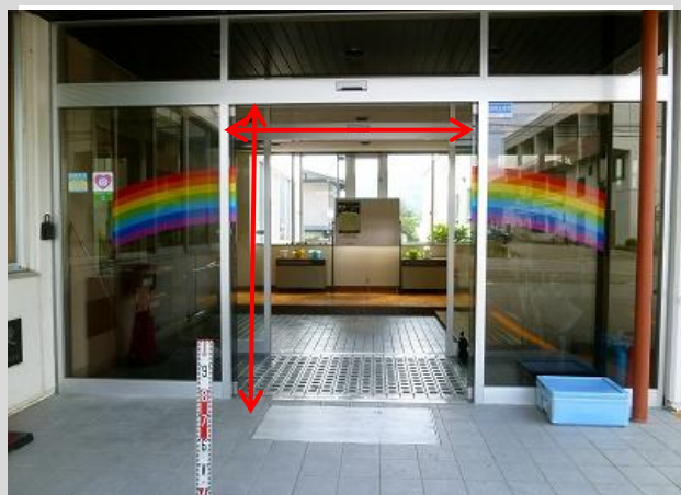
(3) コンテナを搬入する配膳室搬入口
