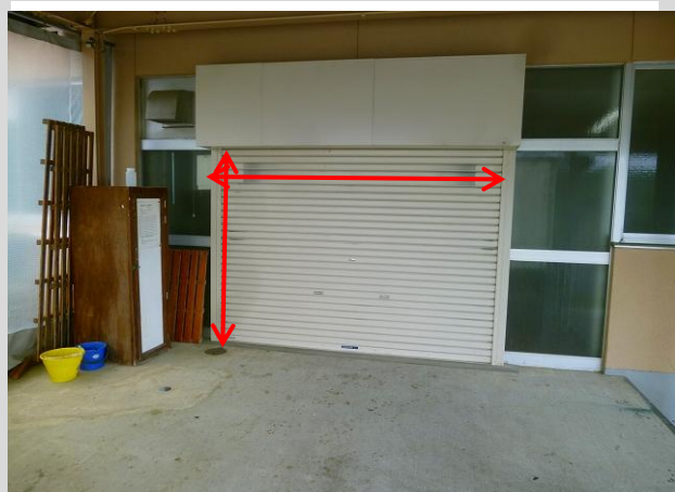
(3) コンテナを搬入する配膳室搬入口
