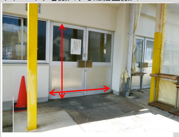
(3) コンテナを搬入する配膳室搬入口
