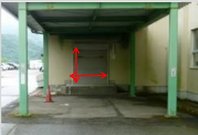
(3) コンテナを搬入する配膳室搬入口
