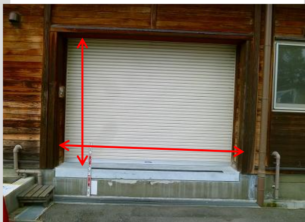
(3) コンテナを搬入する配膳室搬入口
