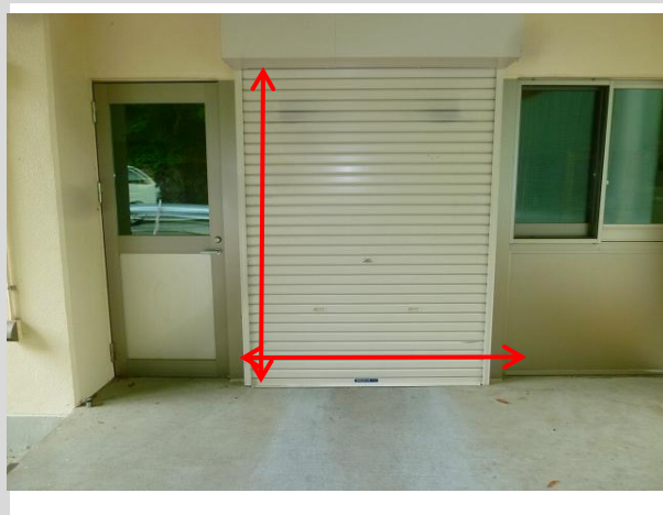
(3) コンテナを搬入する配膳室搬入口
