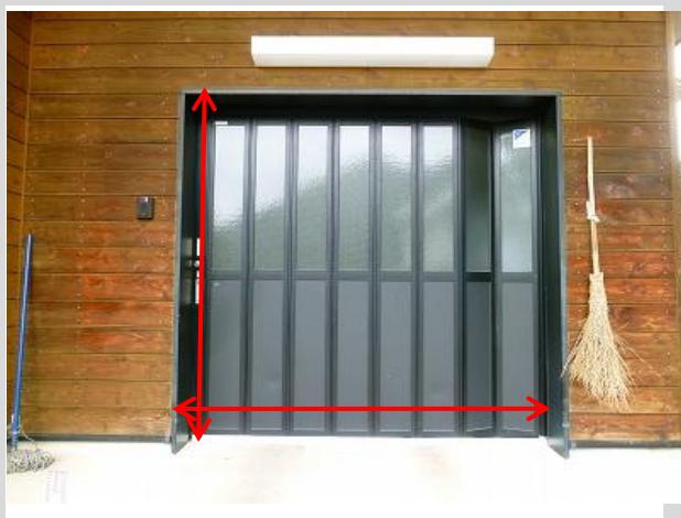
(3) コンテナを搬入する配膳室搬入口
