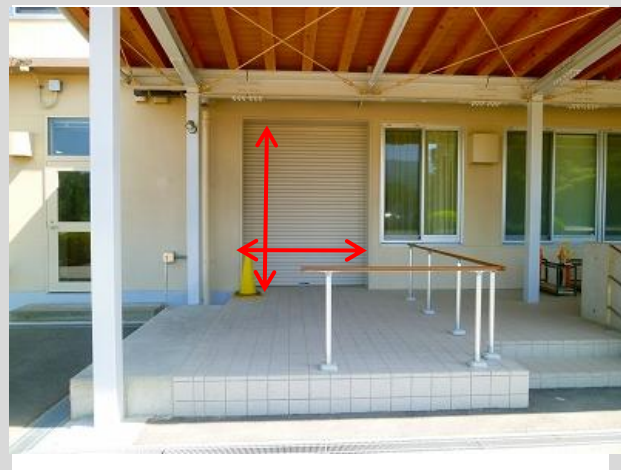
(3) コンテナを搬入する配膳室搬入口
