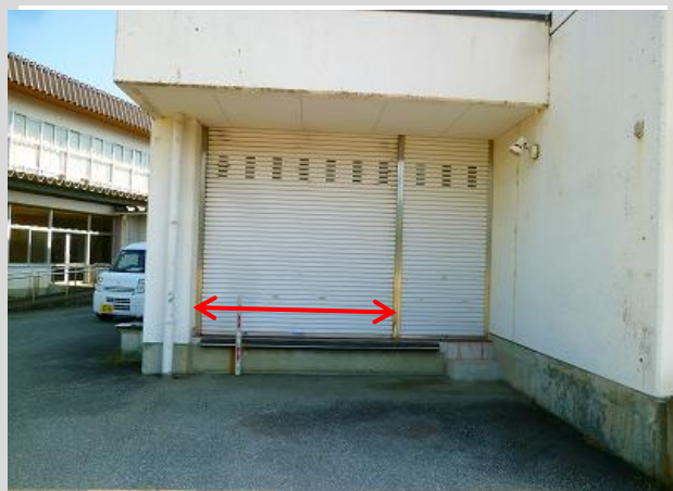
(3) コンテナを搬入する配膳室搬入口
