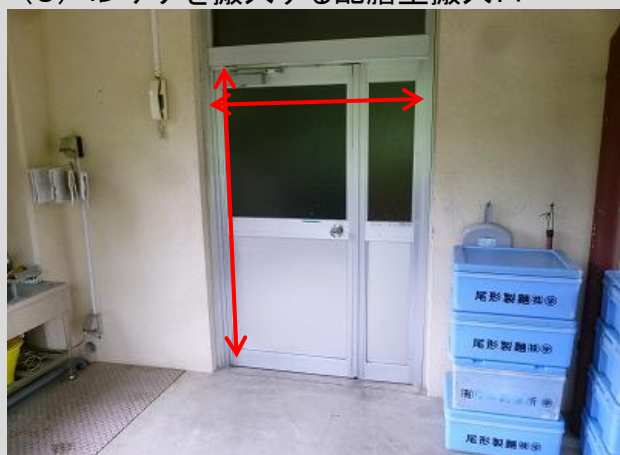
(3) コンテナを搬入する配膳室搬入口
