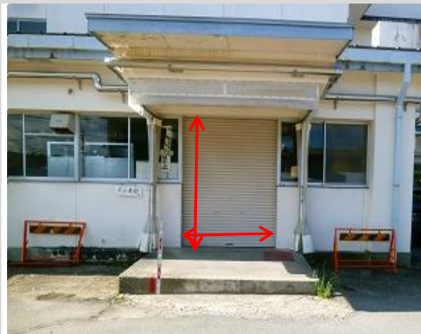
(3) コンテナを搬入する配膳室搬入口
