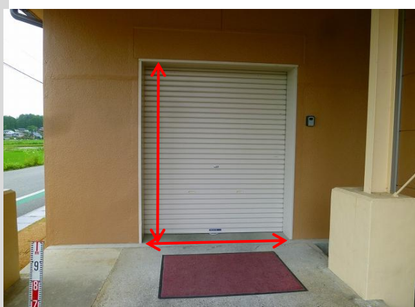
(3) コンテナを搬入する配膳室搬入口
