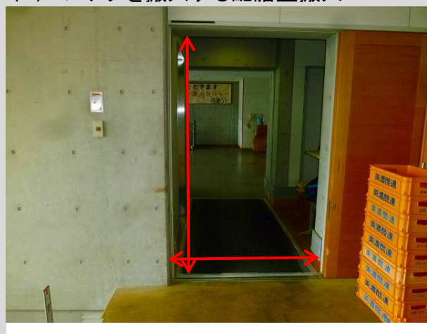
(3) コンテナを搬入する配膳室搬入口
