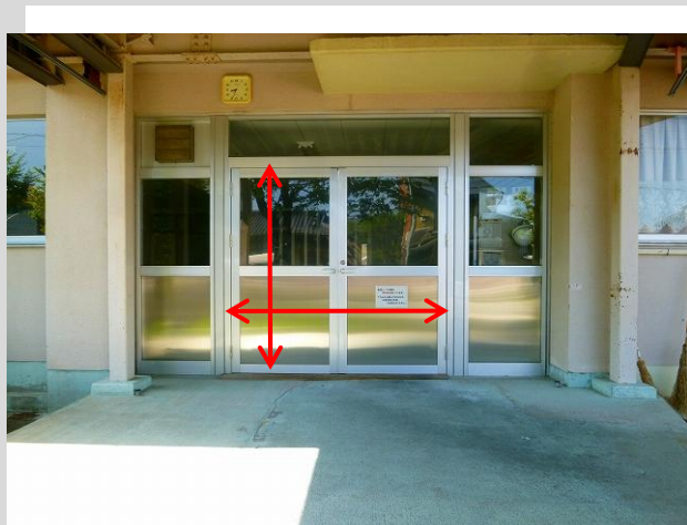
(3) コンテナを搬入する配膳室搬入口
