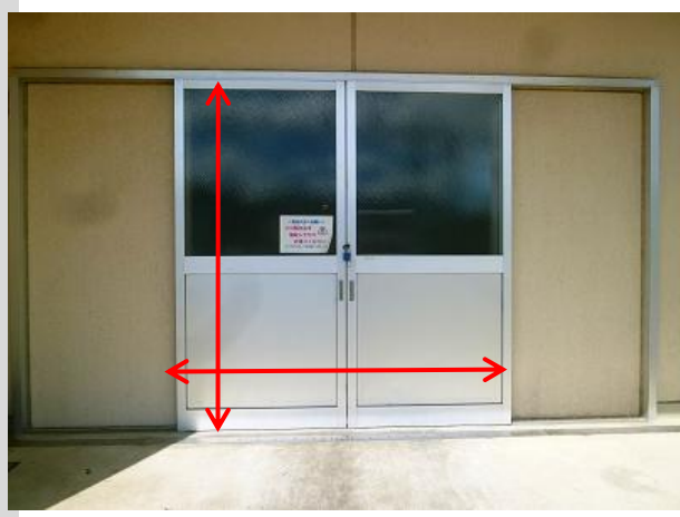
(3) コンテナを搬入する配膳室搬入口
