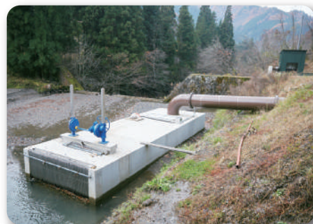
■ 小水力発電所
