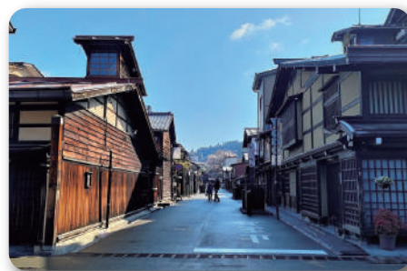
■ 無電柱化整備 （市道上之一町花里線）
