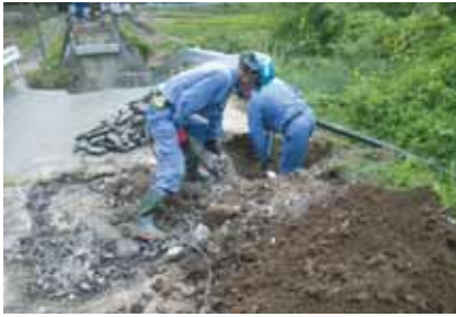
▲水道管復旧工事の様子
