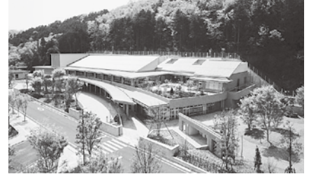
総合斎苑わかくさ（平成17年築：関市）
