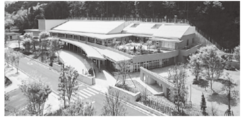
総合斎苑わかくさ (平成17年築：関市)
