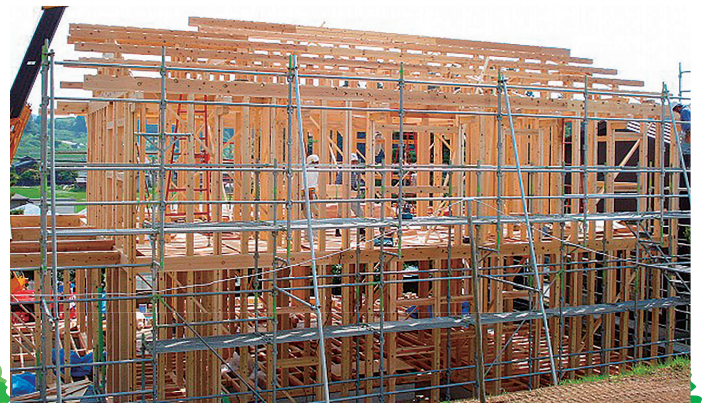
市産材をふんだんに使用した木造建築
