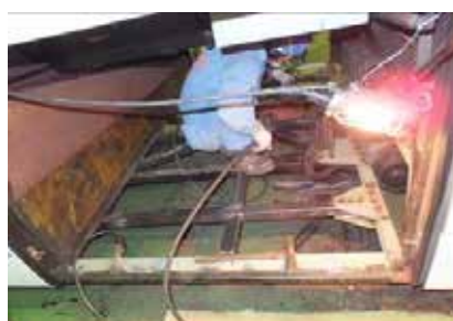
バス下回りの腐食修理
