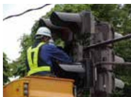
交通信号機工事
