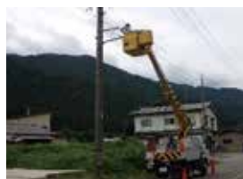
光ケーブル架線工事
