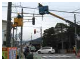
ケーブル架線工事
