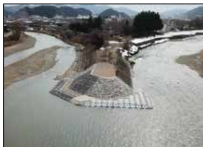
宮川河川工事
