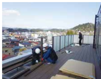
デッキ工事の様子
