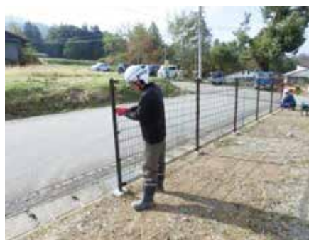
フェンス工事の様子
