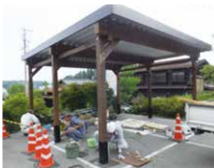
カーポート工事の様子
