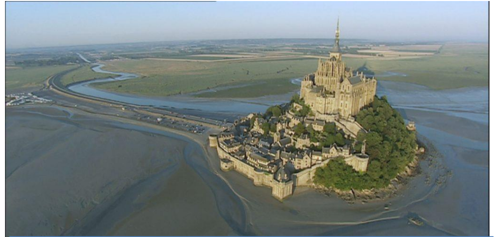
道路でつなげたために砂が滞留して、島が埋まってきた
