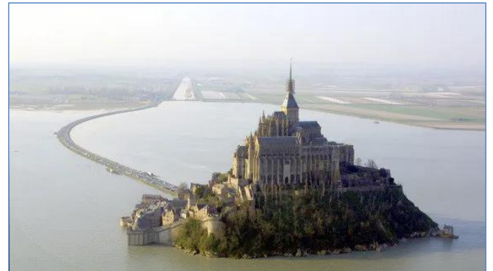
橋げたに代えて、海流が流れるようにした 川の位置も変更
