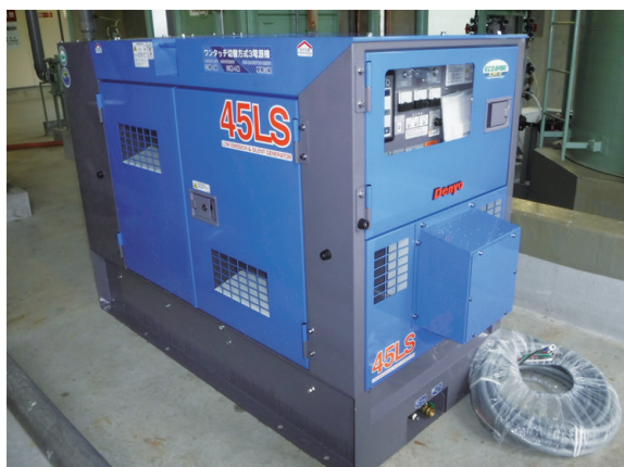
非常用発電機の設置
