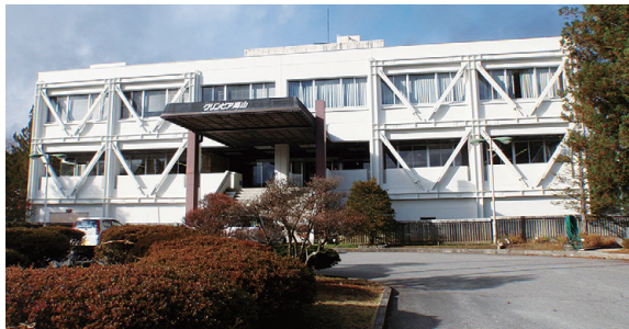
下水道センター
