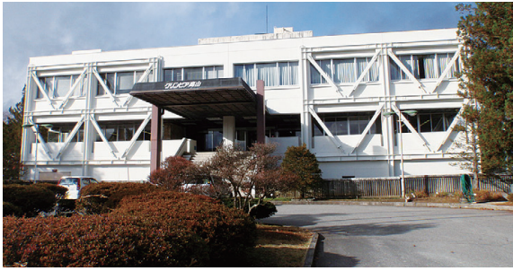
下水道センター
