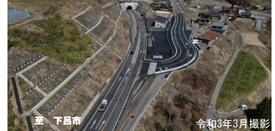
③ 宮峠トンネル （石浦バイパスの一部区間）
