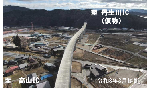
① 下切高架橋（仮称） （高山清見道路の工事中間区間）
