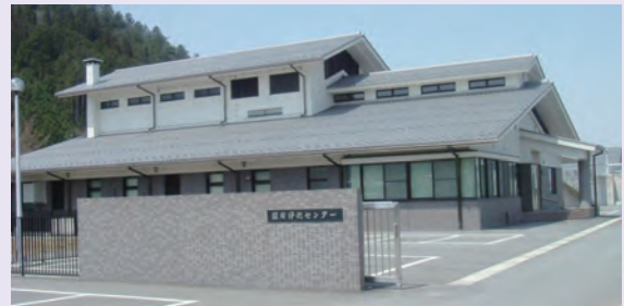
国府浄化センター
