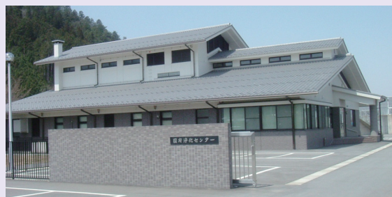
国府浄化センター
