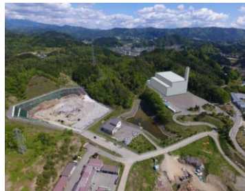
煙突高さ59m
