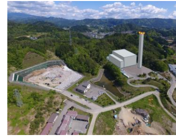
煙突高さ100m
