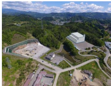
煙突高さ40m
