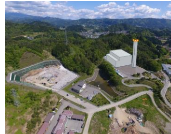
煙突高さ80m
