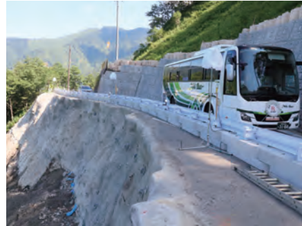
被災現場（復旧後）
