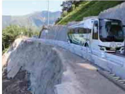
被災現場（復旧後）
