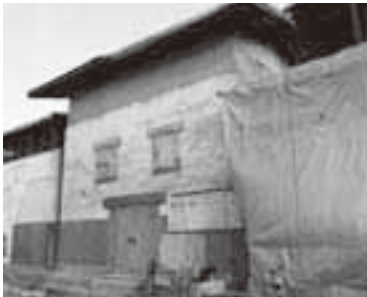
現存する旧矢嶋邸の土蔵
