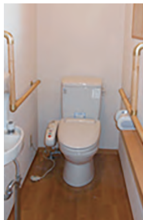
トイレの手すり 取り付け工事
