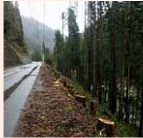
ライフライン保全対策事業
