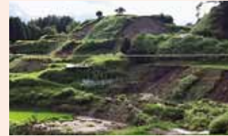
被災した棚田(滝町)
