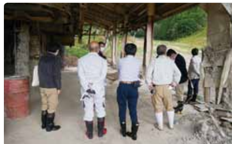
被災した高速ペアリフト乗り場施設
