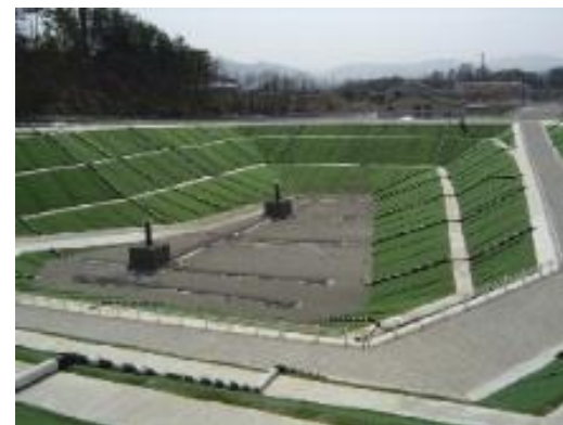
第2次埋立処分地 遮水シート
