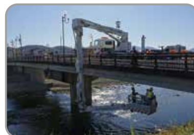
■ 橋りょうの定期点検
