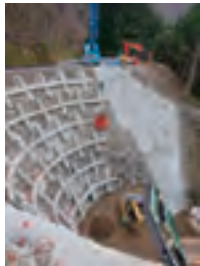
市道塩屋見座線 災害復旧工事現場
