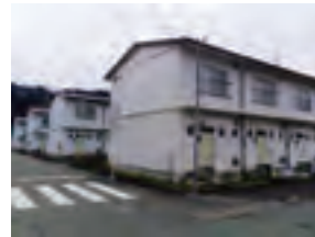
市営住宅 赤保木団地
