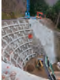
市道塩屋見座線 災害復旧工事現場
