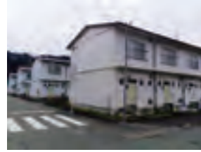
市営住宅 赤保木団地
