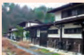
市営住宅下岡本団地
