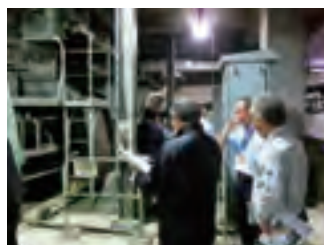
現地調査（沈砂池設備）
