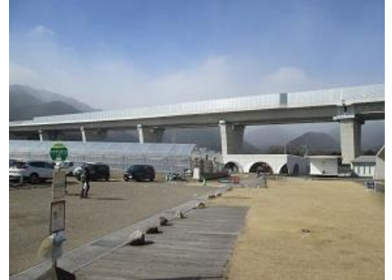
苺のハウスと高架橋
