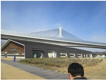
新名神高架橋と施設
