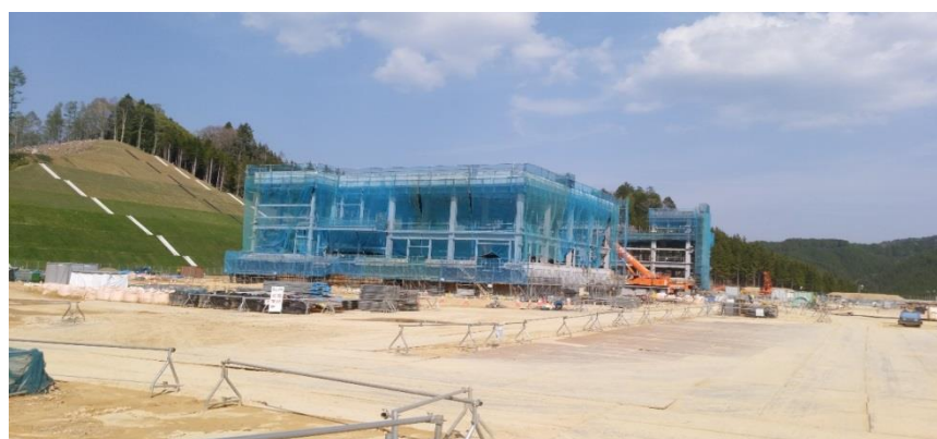
写真：建設中の本館。完成後は無人で自動操作・遠隔操作が行われる。
