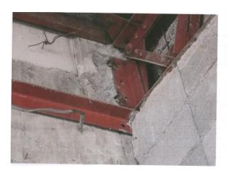
○指定確認検査機関からの指摘による防火上主要な間仕切り壁を準耐火構造から耐火構造とする工 事内容の変更(教室廊下を隔てる壁)
