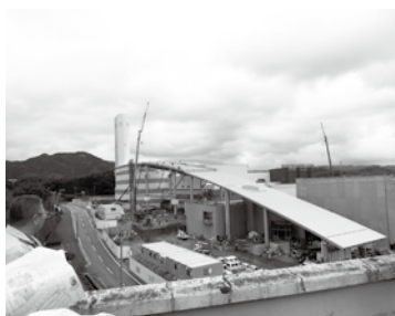
建設中の新ごみ焼却施設
