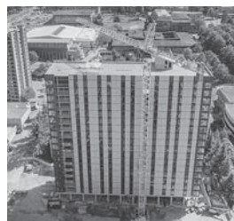
木造(CLT)の18階建ビル
