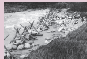
宮川防災ダムが無かったところの一之宮町の水害(伊勢湾台風)
