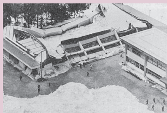
豪雪で倒壊した荘川中学校体育館
