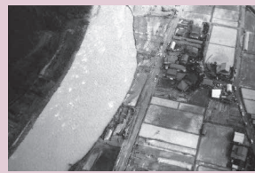
豪雨により川岸が大きく崩壊した川上川
