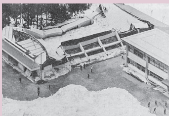
豪雪で倒壊した荘川中学校体育館
